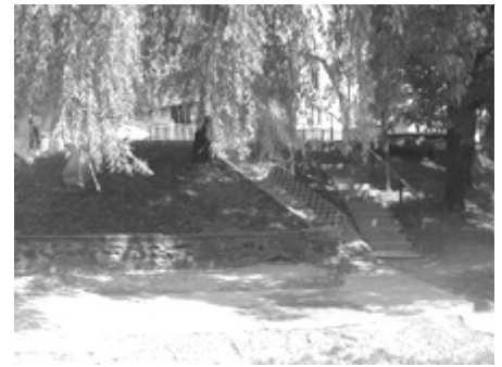
Upravený svah a nové schody na Ťahanovskej ulici
